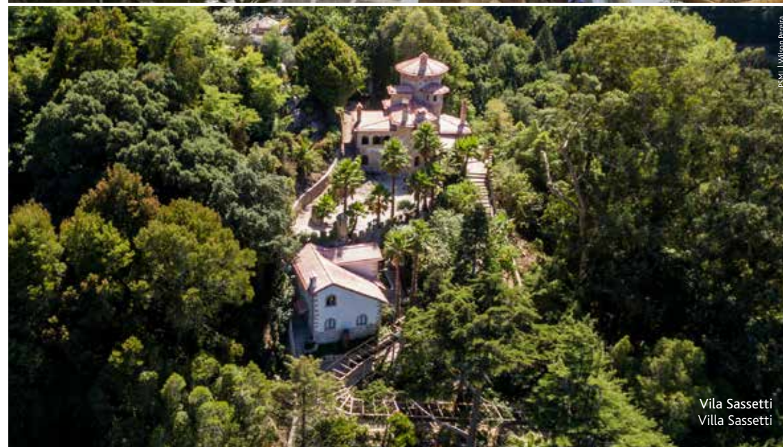
Vila Sasseti - Casa do Caseiro Villa Sasseti - Caretaker's House
